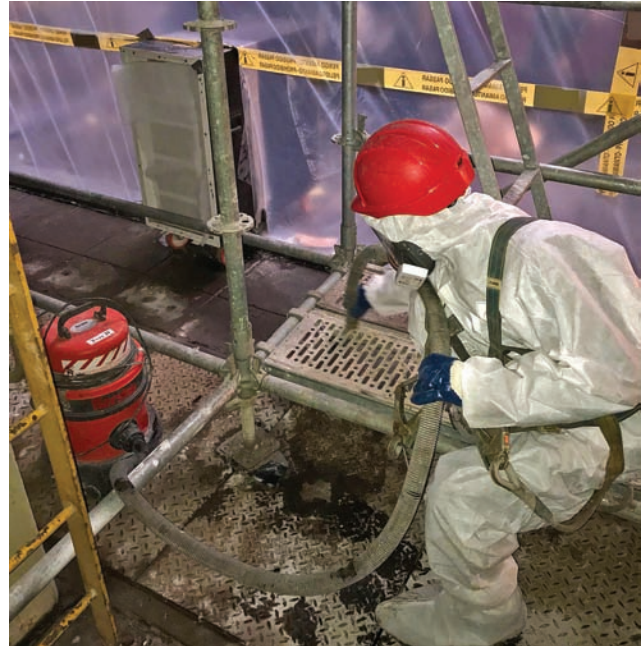
Figura 14. (a) Limpieza de superficies y plásticos mediante aspiración con filtro HEPA.
