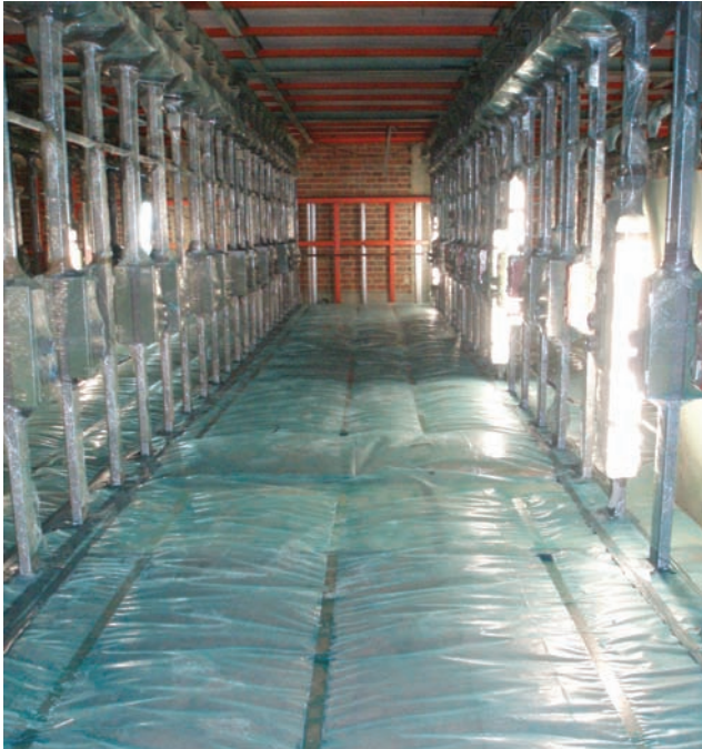
Figura 5. Protección de elementos no retirados de la zona de trabajo para evitar su contaminación. El color azul del suelo representa el encapsulante utilizado en el proceso de limpieza final.
