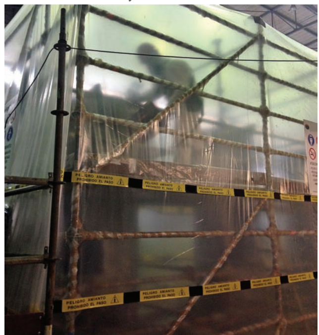
Figura 7. Burbuja protectora de la zona de trabajo.
