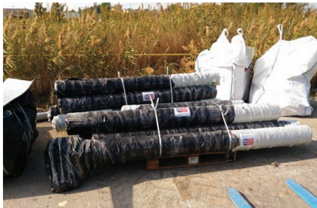
Figura 16. (a) Residuos de amianto acondicionados y acopiados para su retirada.
