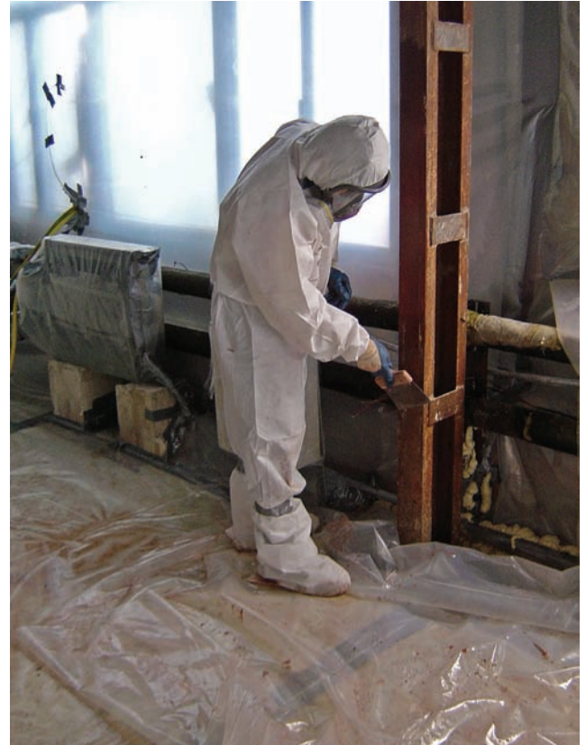
Figura 12. (a) Uso de herramientas manuales: rasqueta.
