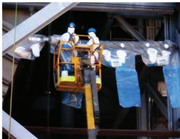
Figura 2. Retirada del calorifugado de una conducción mediante bolsa de guantes.
