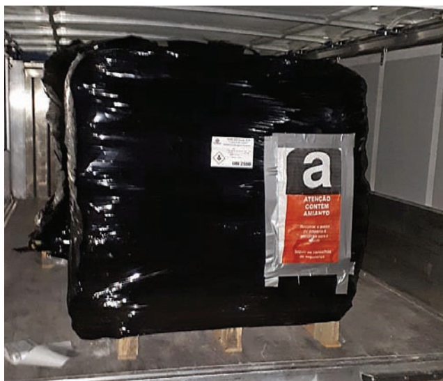
Figura 16. (b) Residuos de amianto acondicionados y dispuestos para su transporte.
