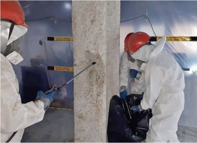
Figura 11. Humectación de materiales con amianto para facilitar su retirada manual.
